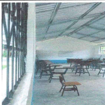
Foto 3: EN ESTA FOTOGRAFIA SE OBSERVA LA PARED, Y LA PINTADA INTERIOR DEL PROYECTO.
