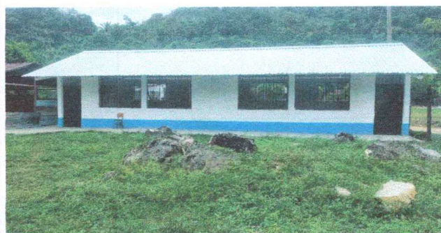
Foto 4: ASI SE OBSERVA DESDE EL EXTERIOR DE LA ESCUELA LUEGO DE FINALIZAR LA EJECUCION AL 100%
