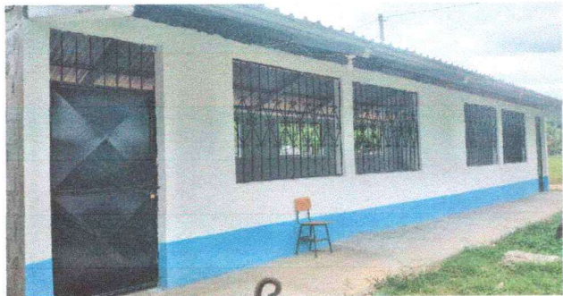
Foto1: ES UNA DE LAS FOTOGRAFIA DEL PROYECTO DESPUES DE LA INSTALACION DE LAS PUERTAS Y BALCONES.
